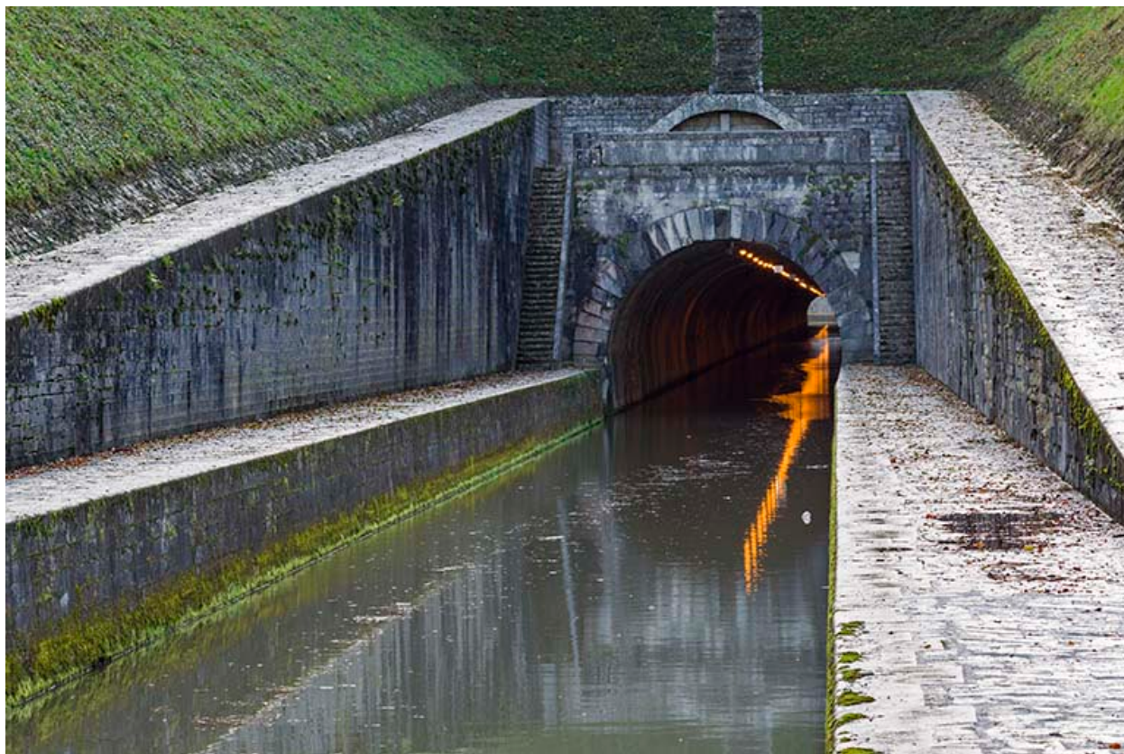
Le tunnel de Saint-Albin.
