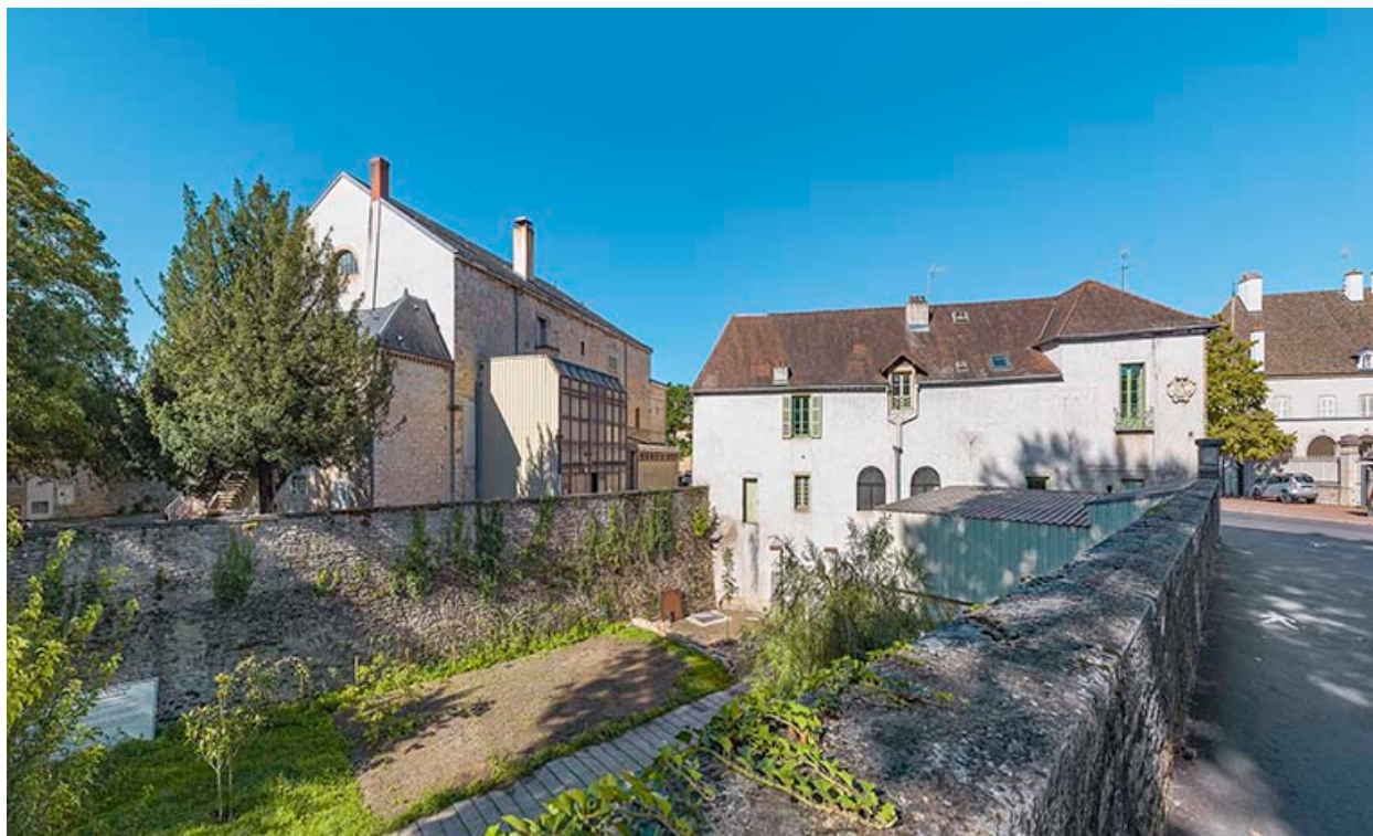
Mur de l'ancien bastion.
