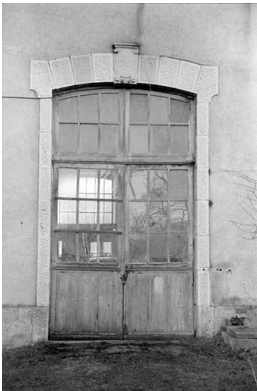
Porte d'entrée de la centrale hydroélectrique.
