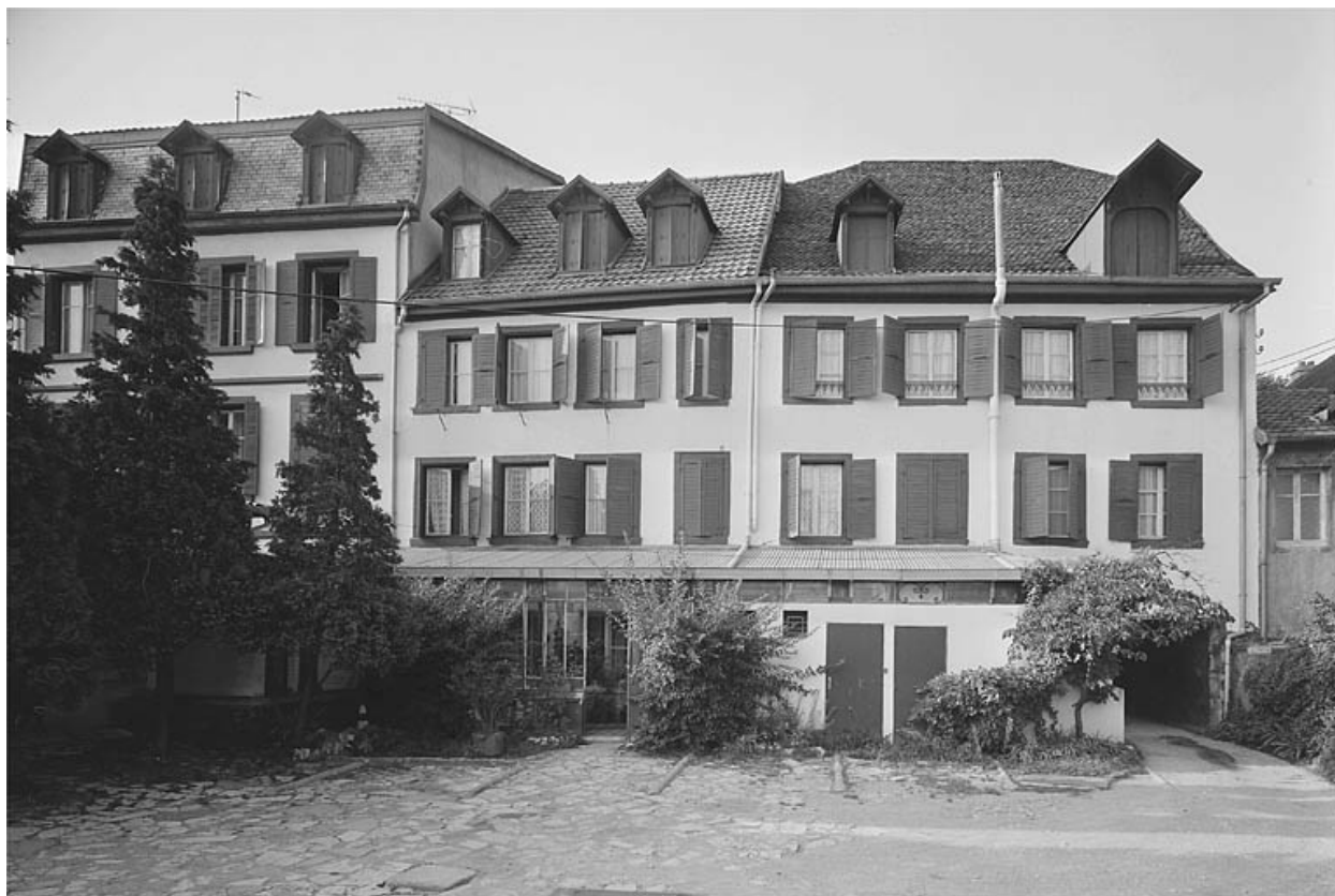
Façades sur jardin.
