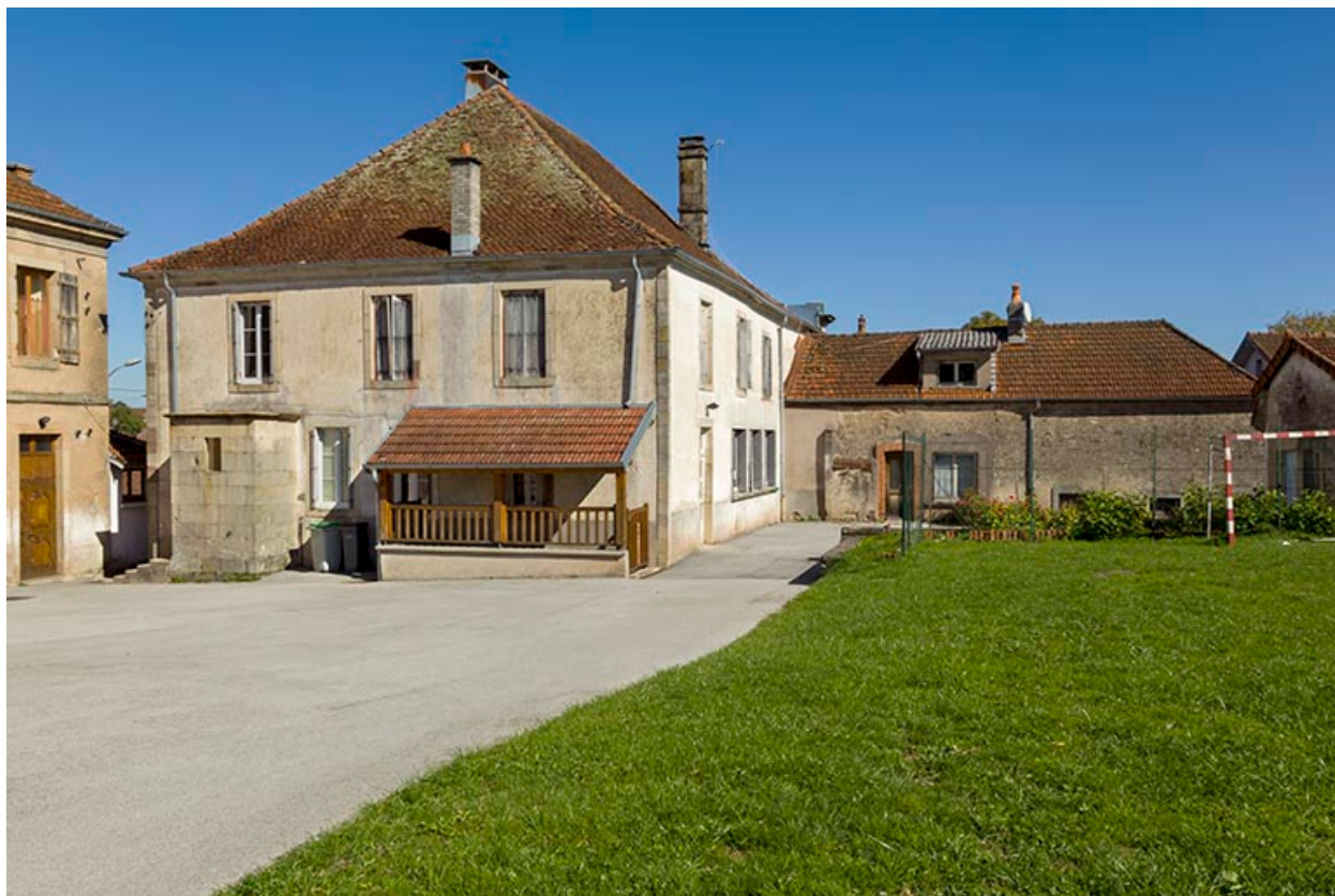
Façade postérieure de la mairie.
