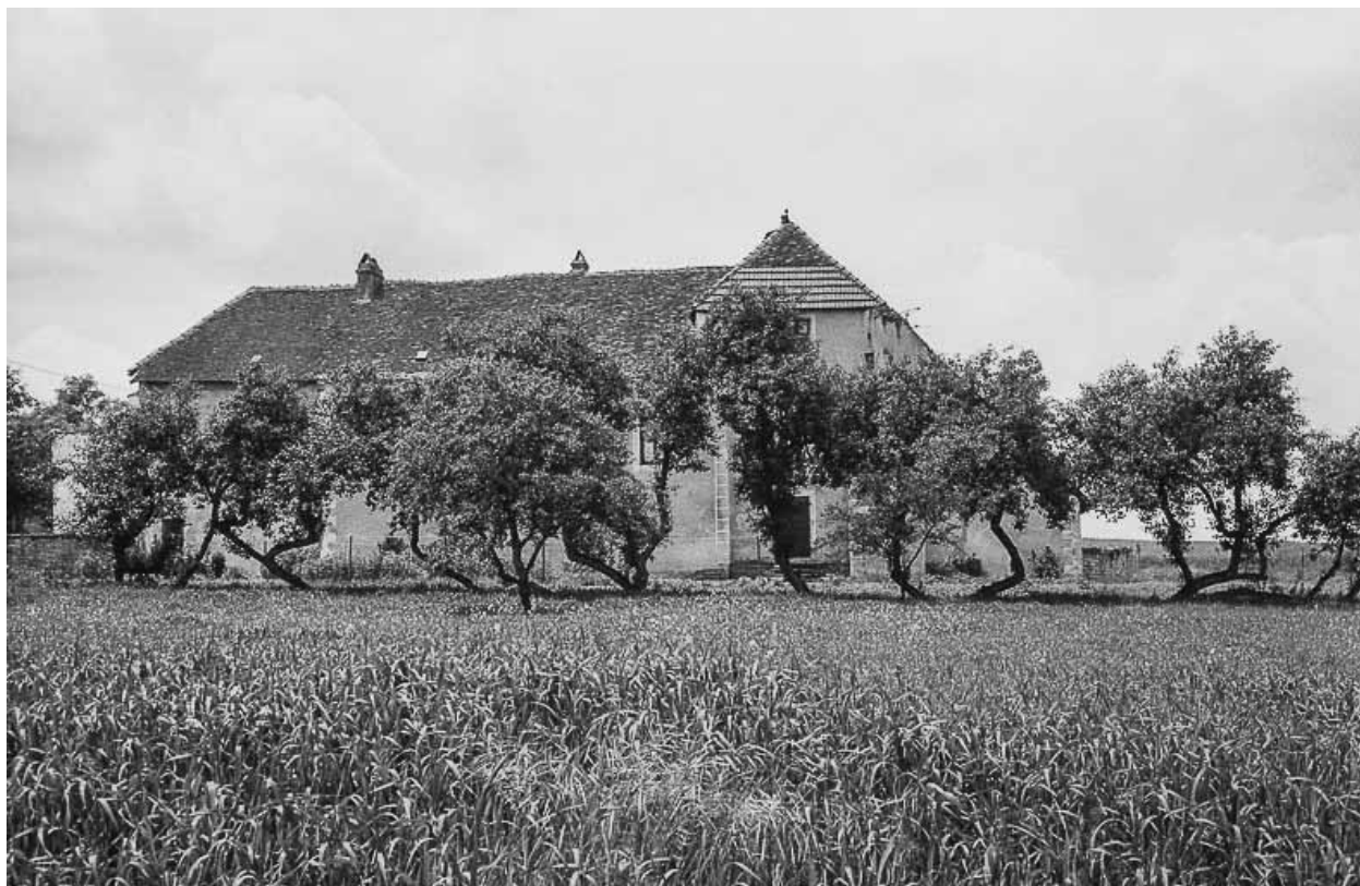
Façade postérieure du bâtiment.
