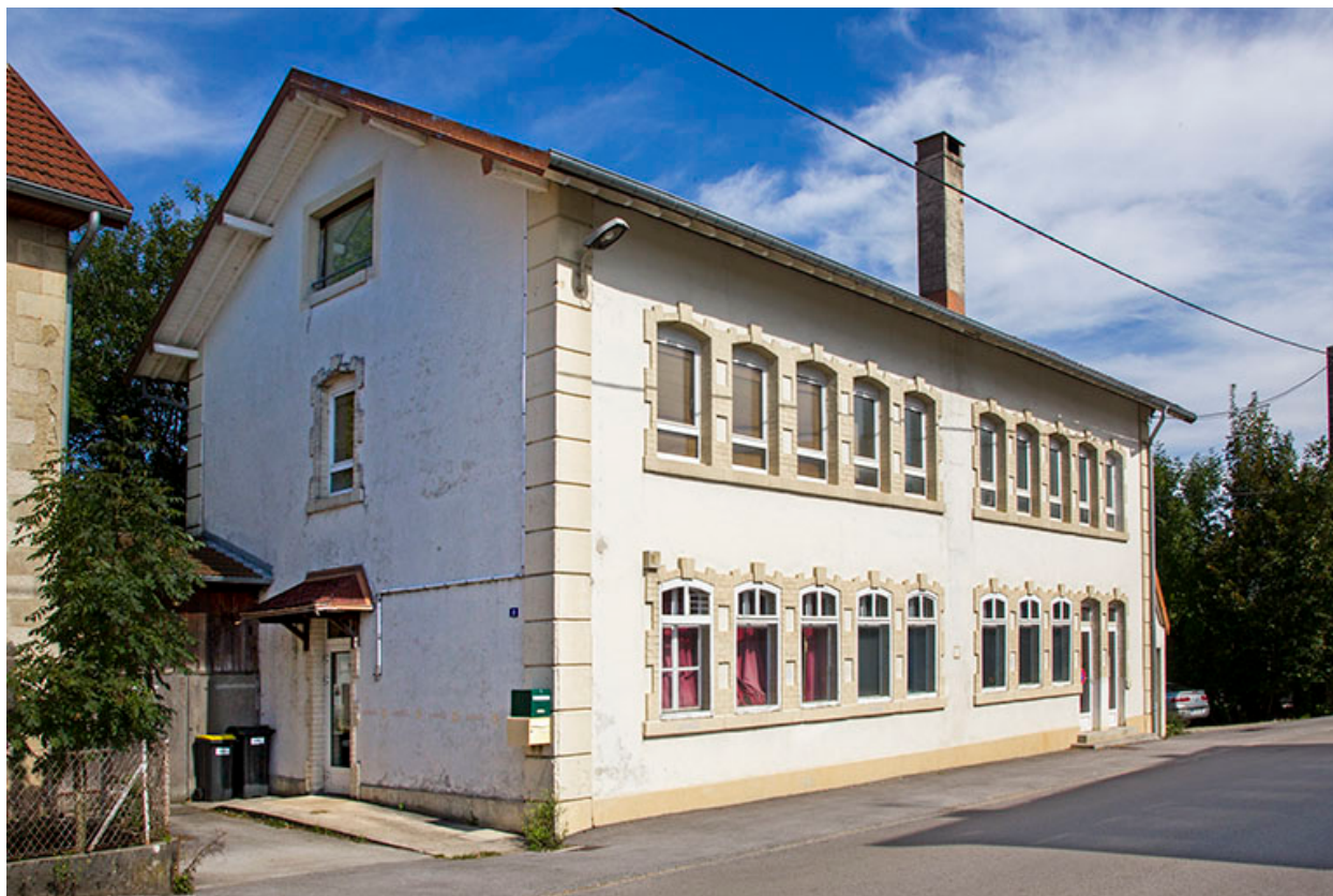
Façades antérieure et latérale gauche.
