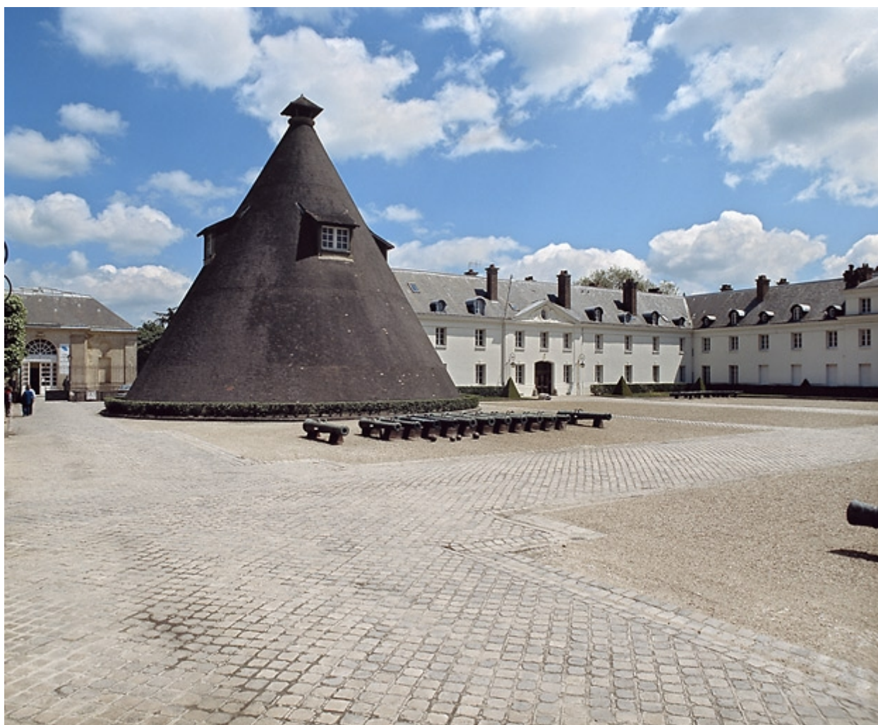
Vue d'ensemble, depuis l'ouest, en 1996.
