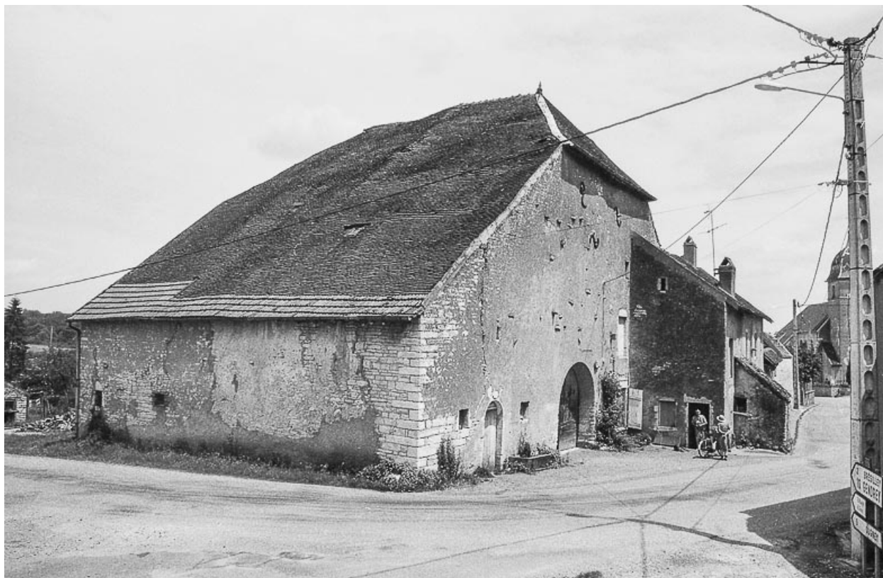
Façades antérieure et latérale gauche.
