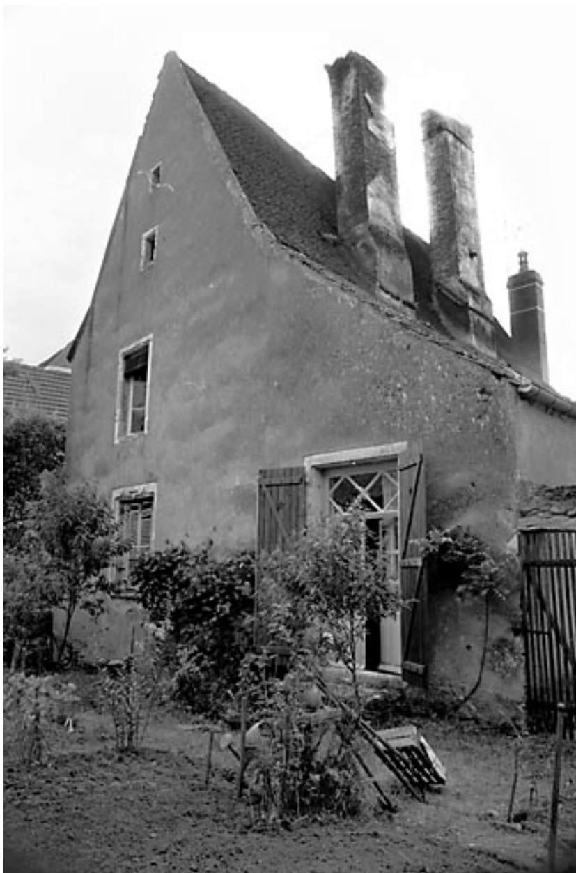
Maison située rue Sainte-Anne : vue d'ensemble.
