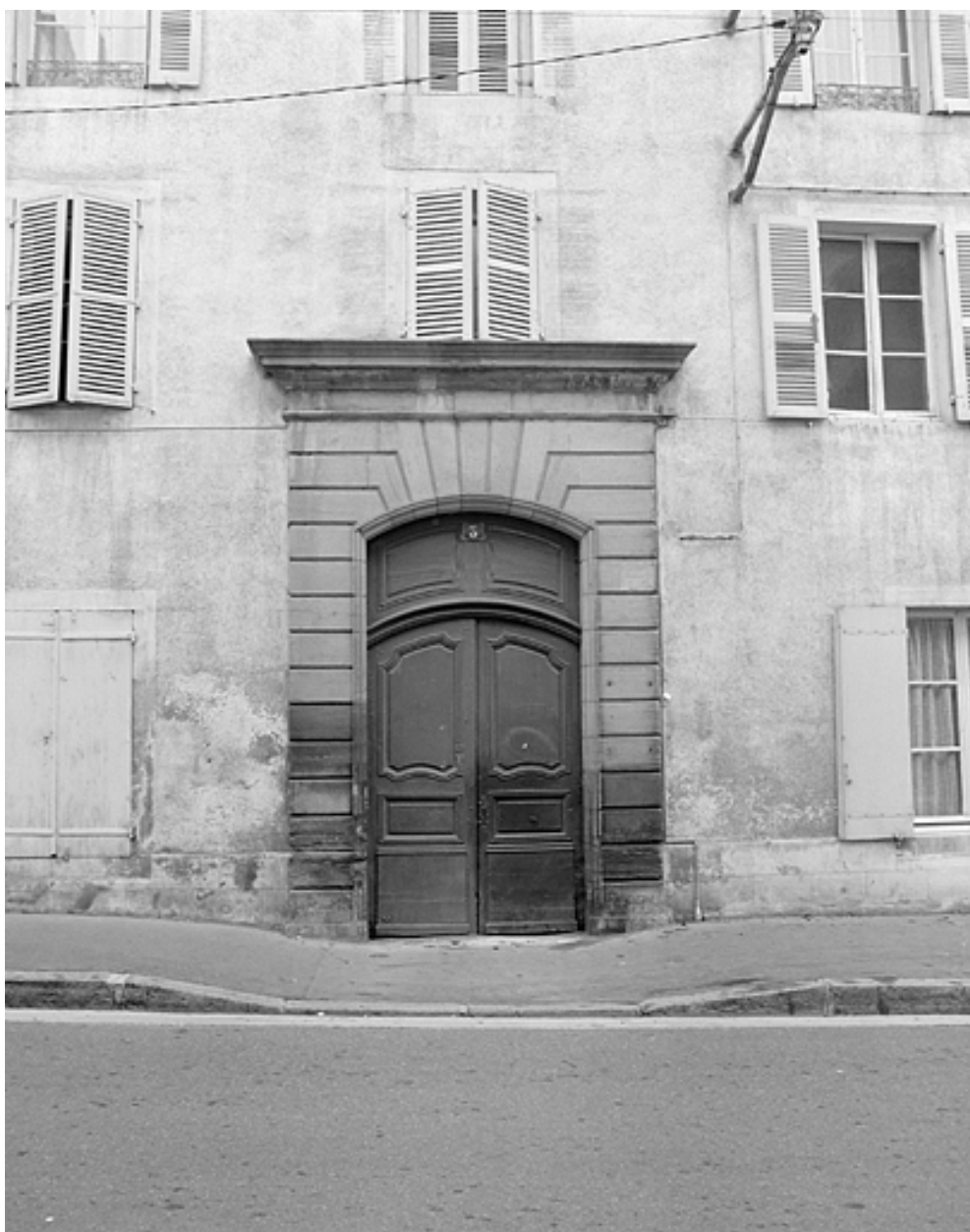
Façade antérieure, portail.
