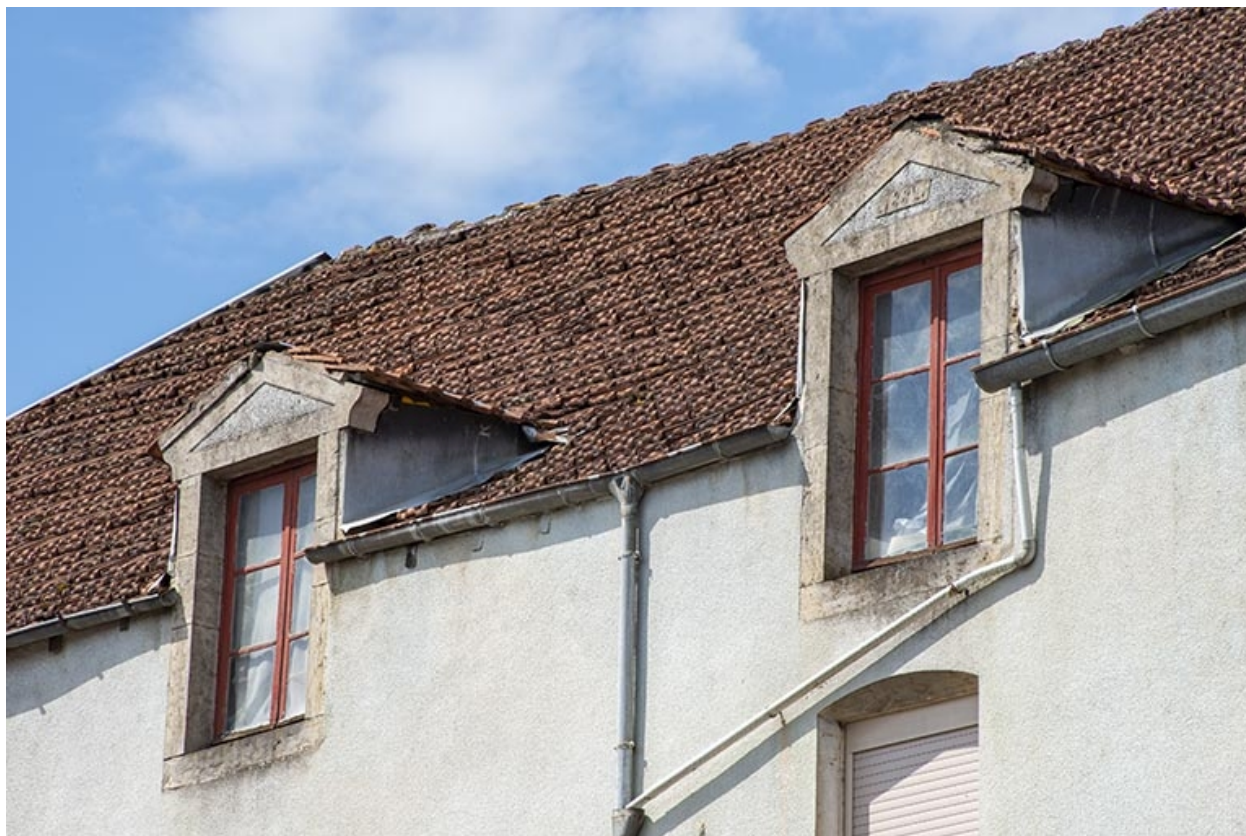
Les deux lucarnes du surcroît.
