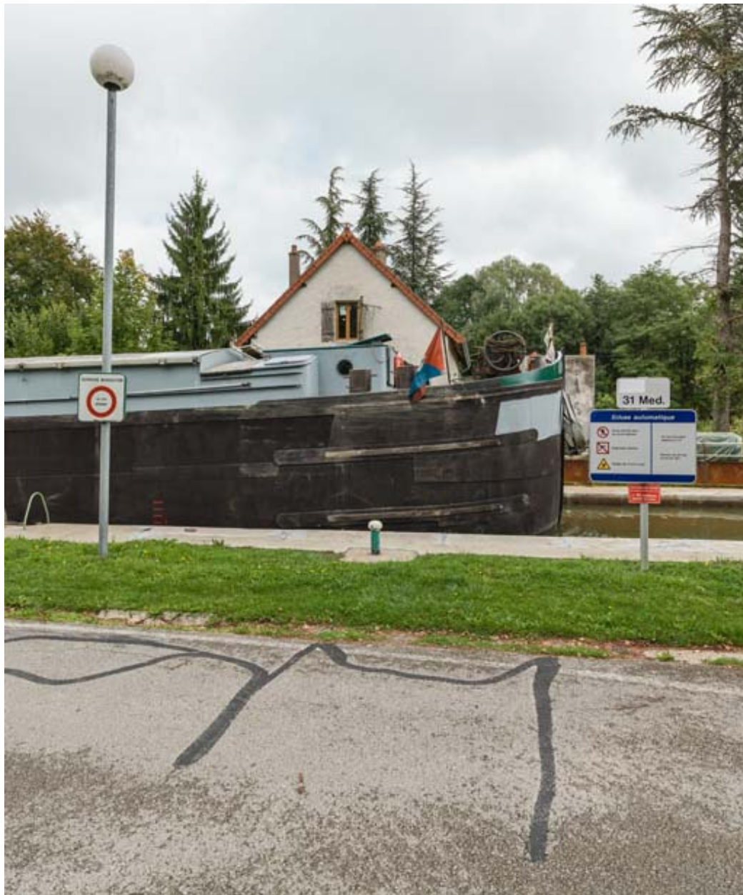
Vue rapprochée de l'écluse.
