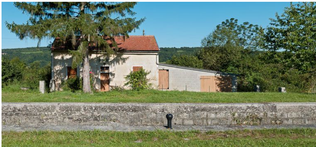
Vue de face de la maison éclusière.
