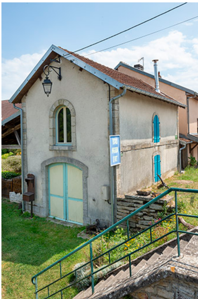
Magasin servant à la maintenance du pont-tournant.
