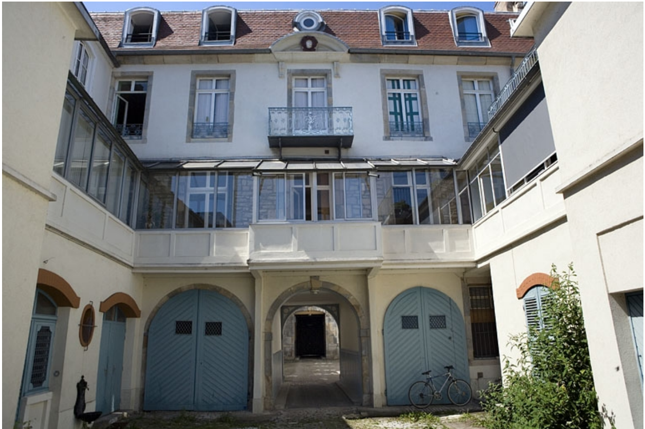
Façade postérieure du logis secondaire, de face.
