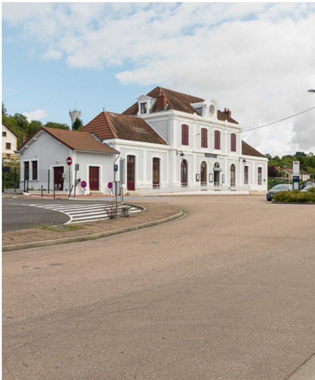
Vue de la gare.
