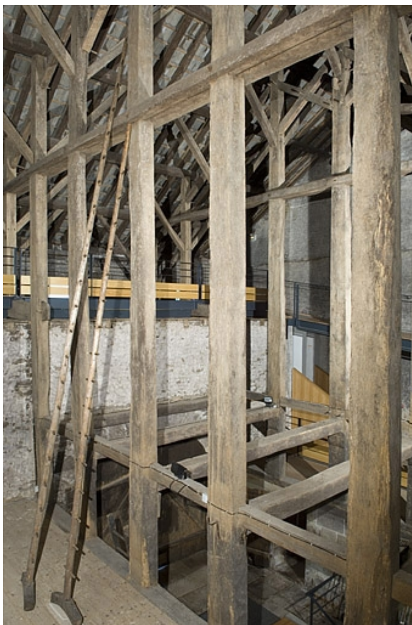
Charpente du fenil. Vue plongeante.
