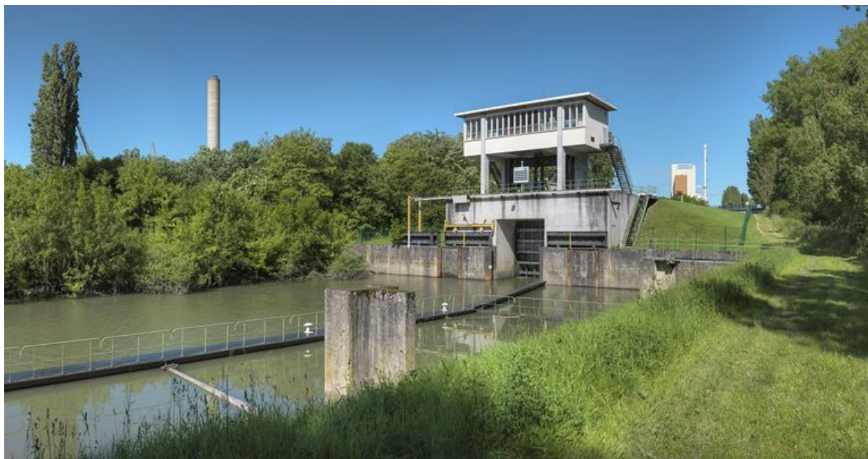
Vue d'ensemble d'aval.
