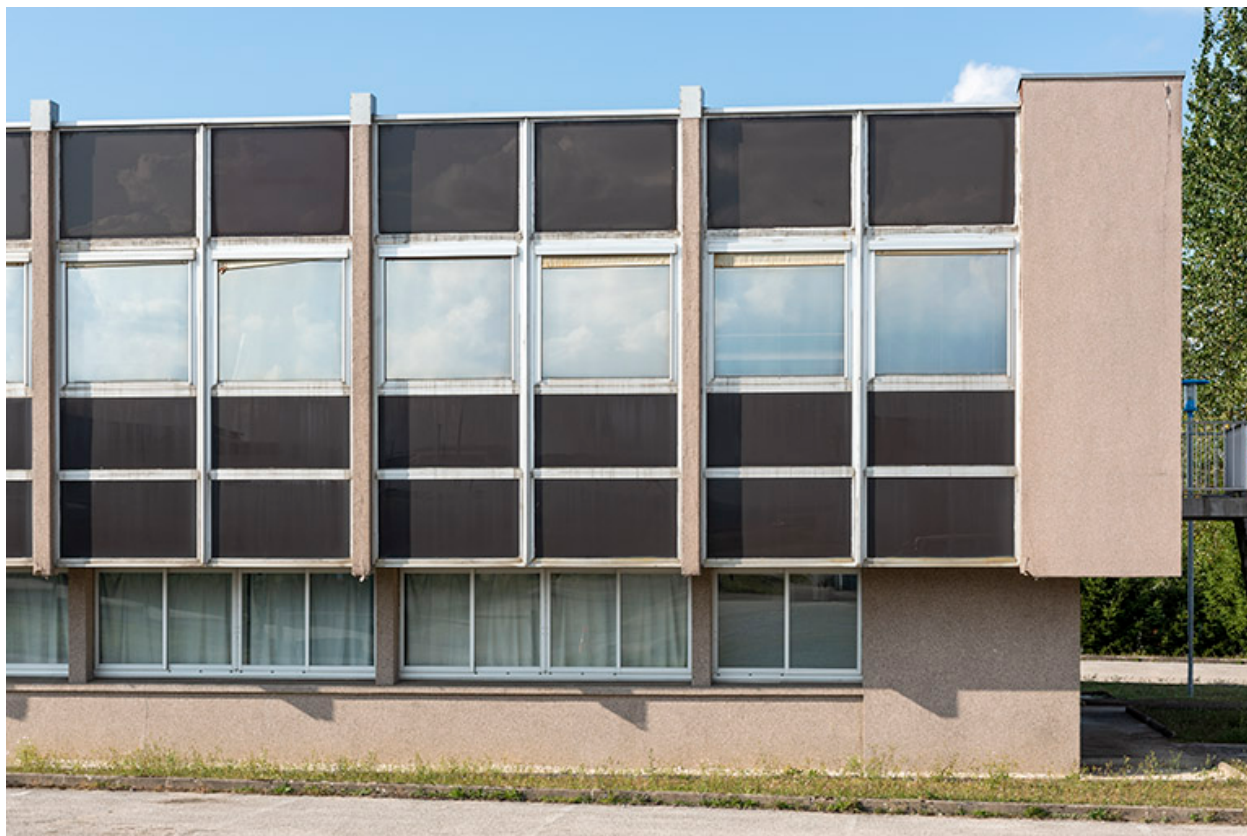
Façade antérieure : extrémité droite.
