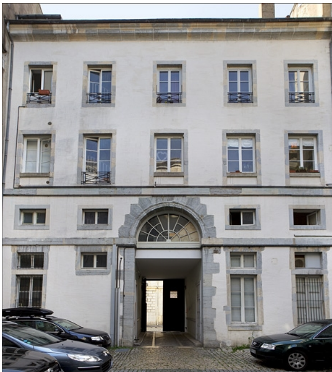
Façade postérieure, de face.
