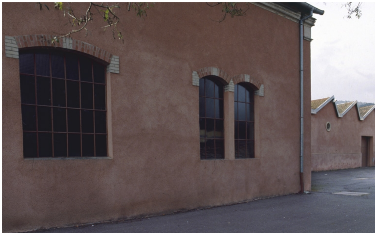
Détail de baies.
