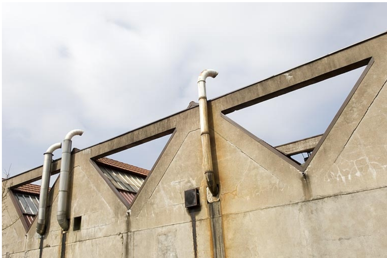
Pignons de l'atelier de fabrication.
