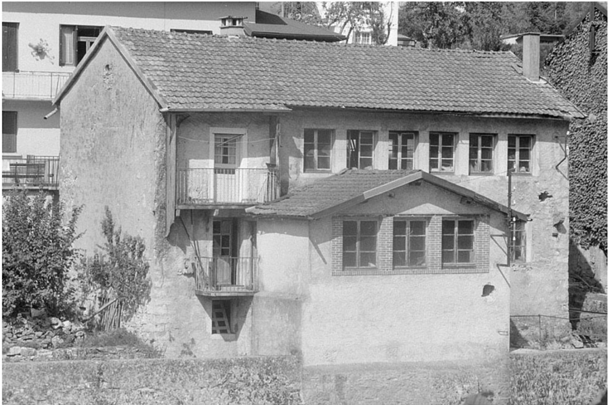
Atelier de fabrication et salle des machines.
