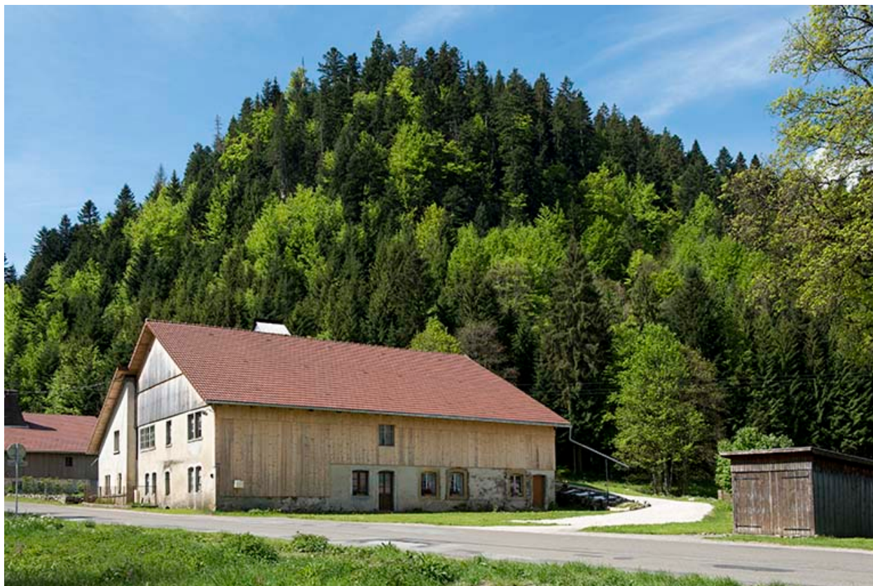
Façades nord et est.
