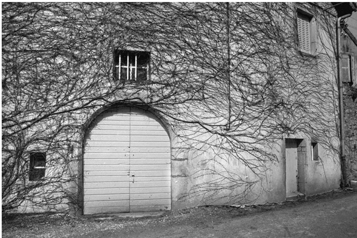
Maison cadastrée 1964 AB 13 : porte de grange.
