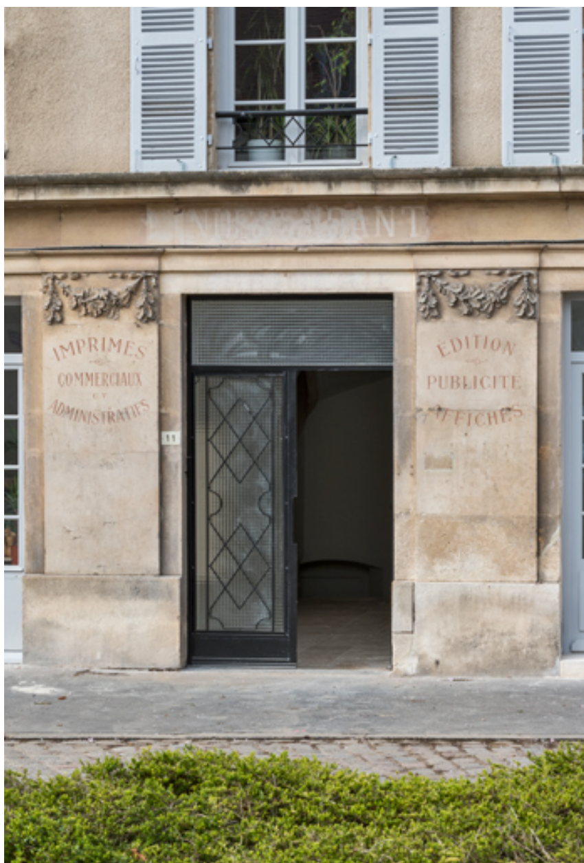
Façade antérieure : entrée.
