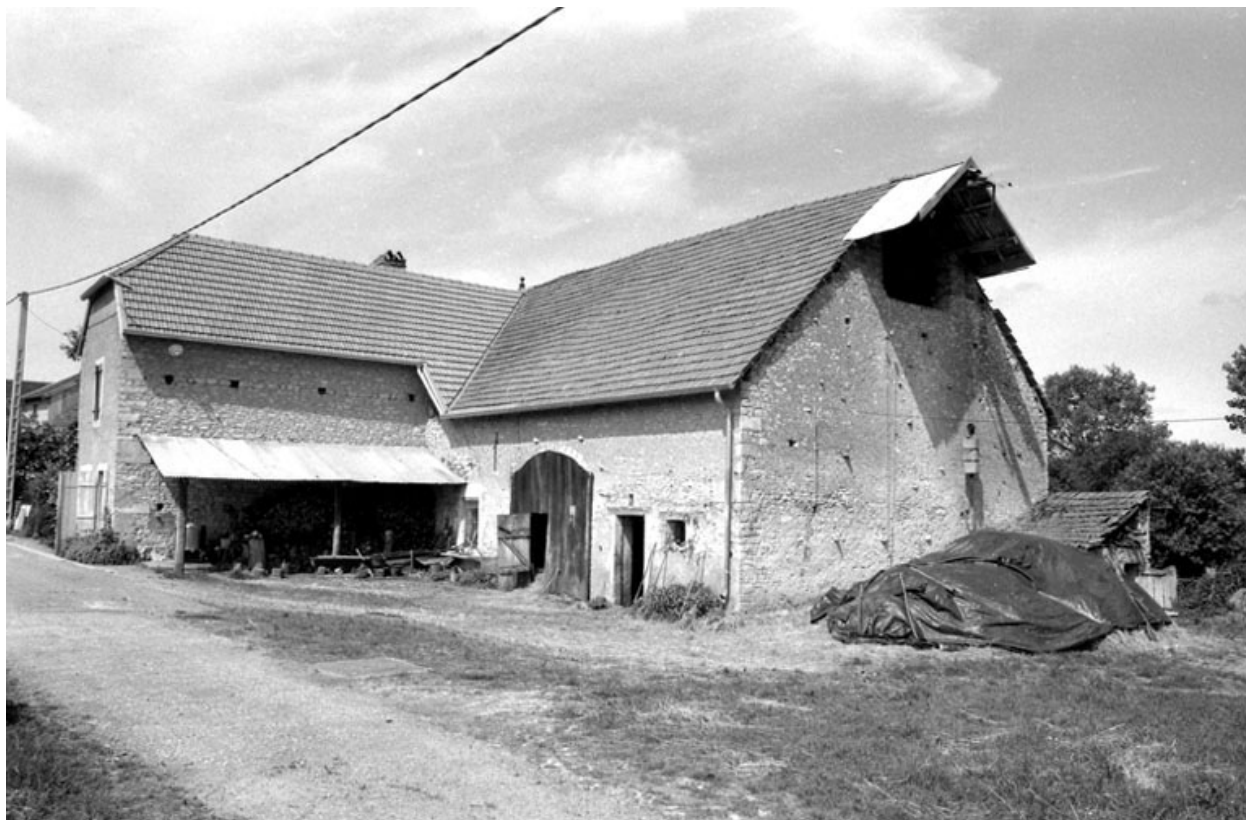
Vue d'ensemble depuis la rue Cazelle.
