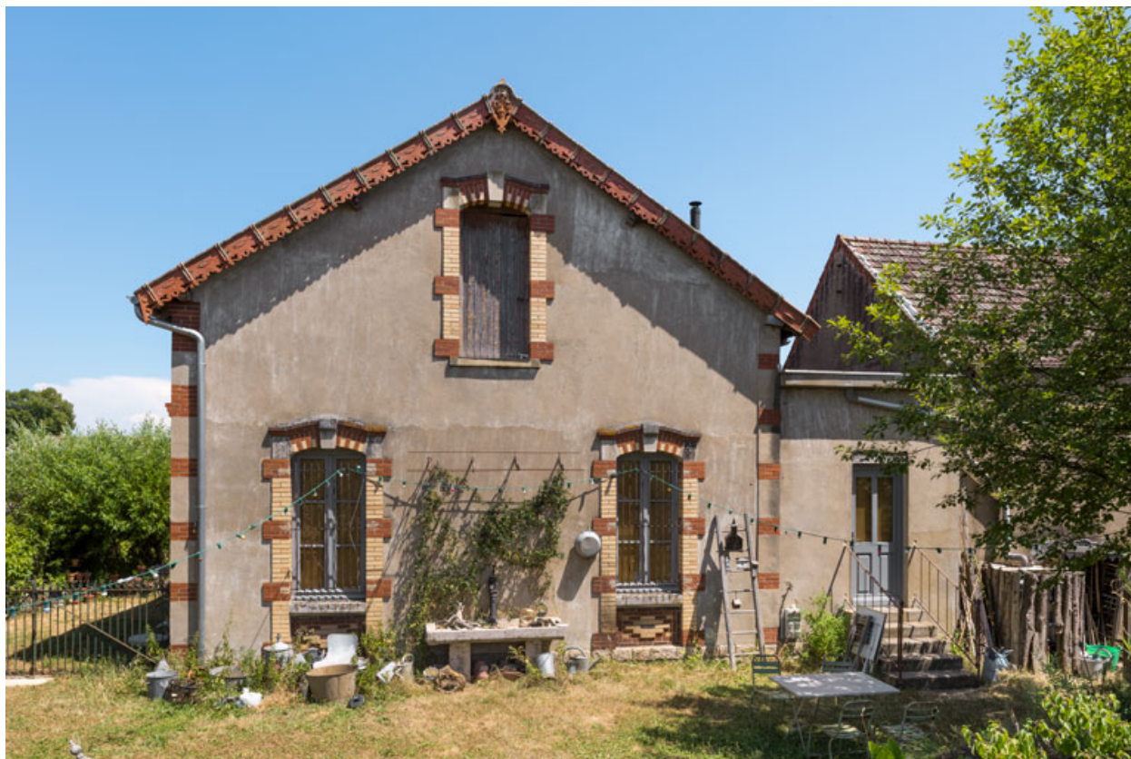
Salle de bal : façade latérale droite.
