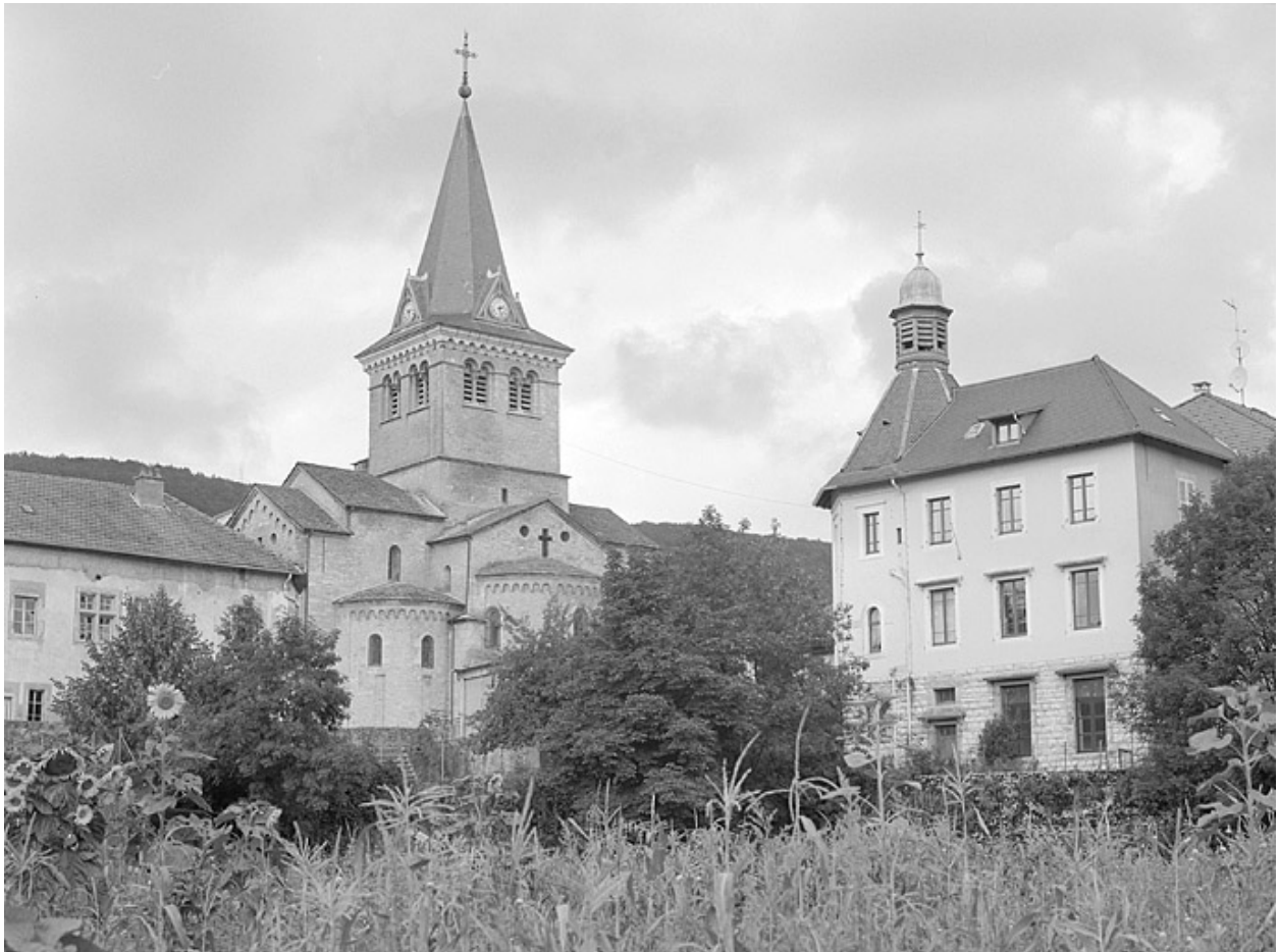
L'église paroissiale et l'ancienne mairie.
