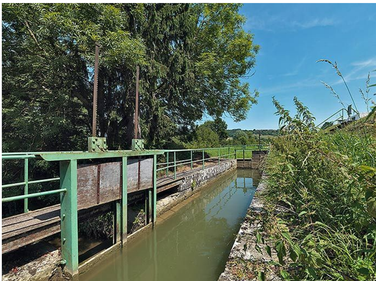
Vannes de régulation sur la rigole.
