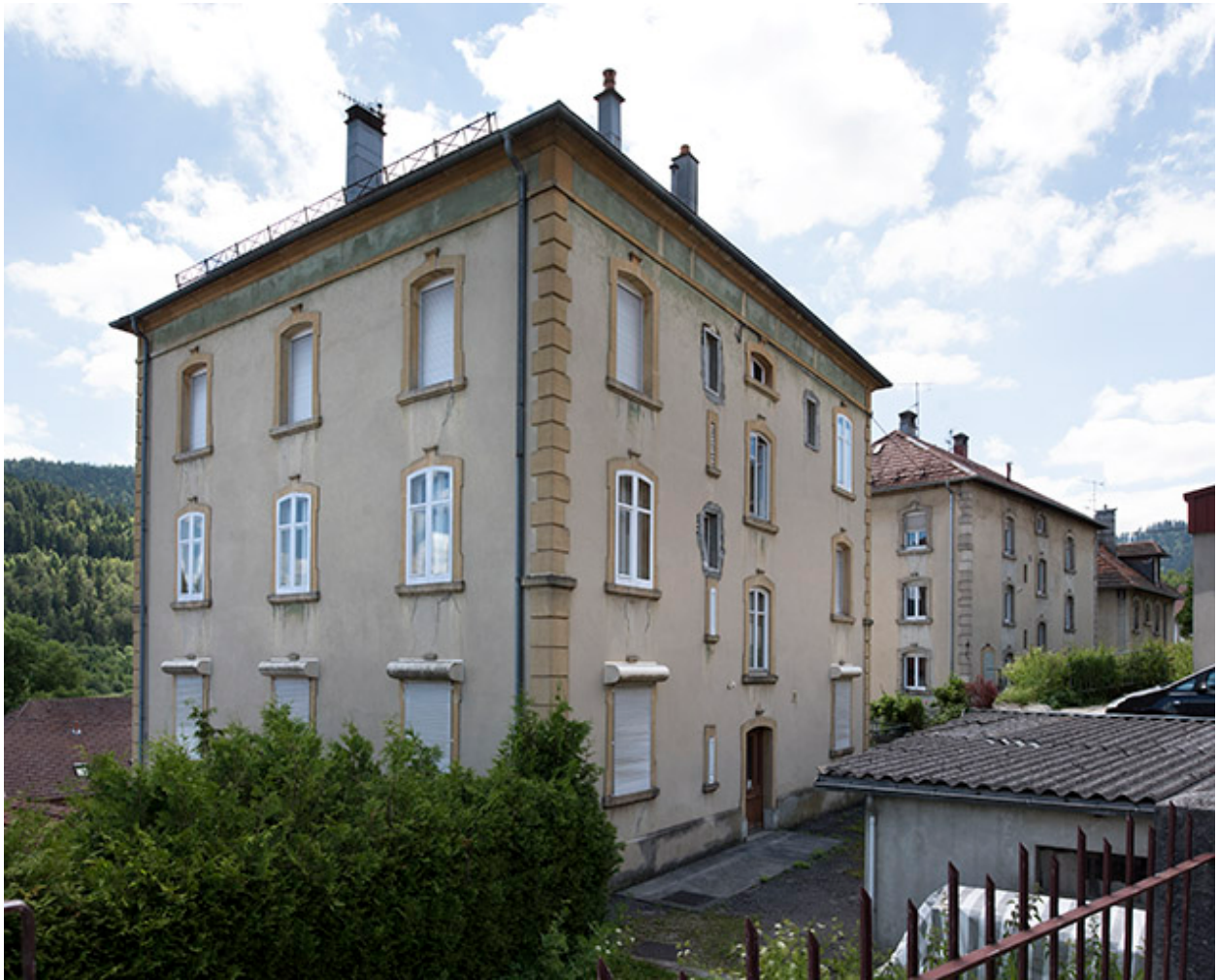
Façades postérieure et latérale droite.
