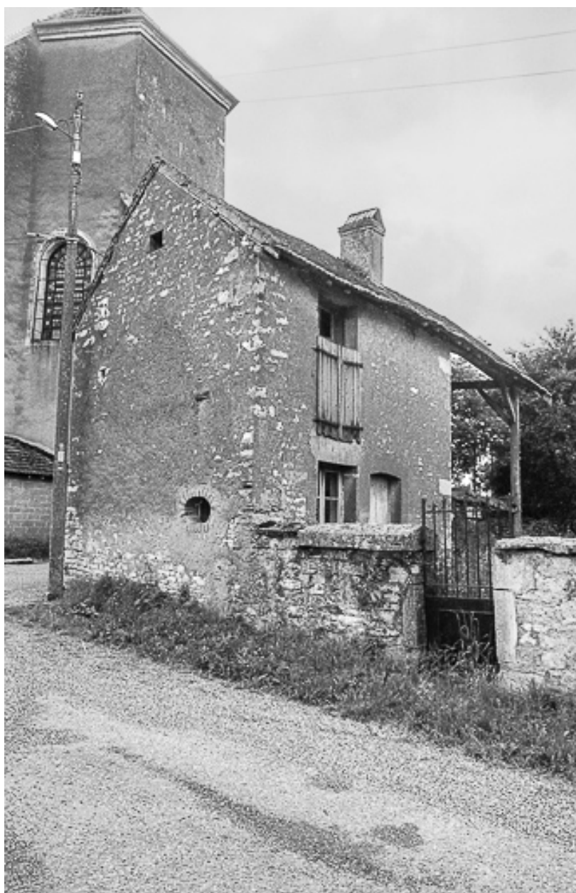
Petit logement à l'angle de la cour.
