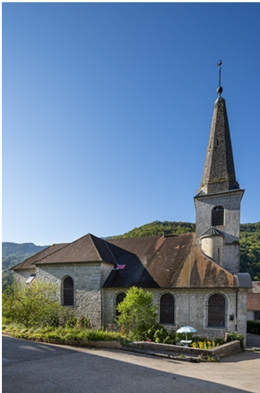
Façade latérale gauche en 2021.
