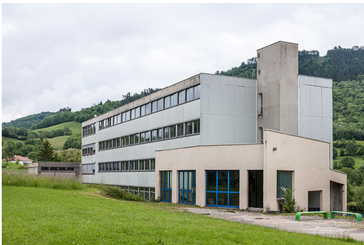
Angle nord-ouest de l'internat de filles.
