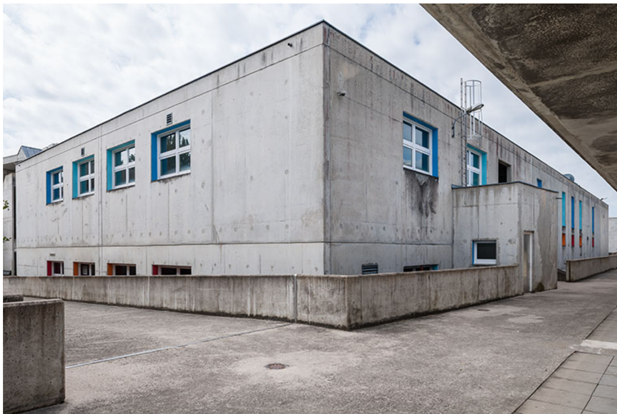
Atelier métal : façade latérale.
