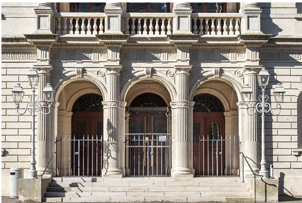
Façade antérieure : baies du rez-de-chaussée.
