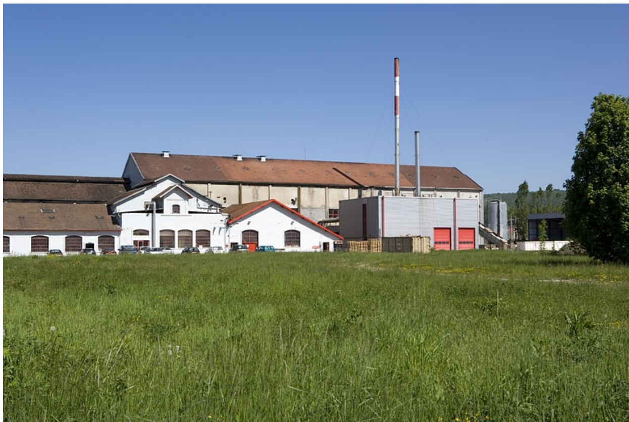
Atelier de trituration. Vue depuis le sud.
