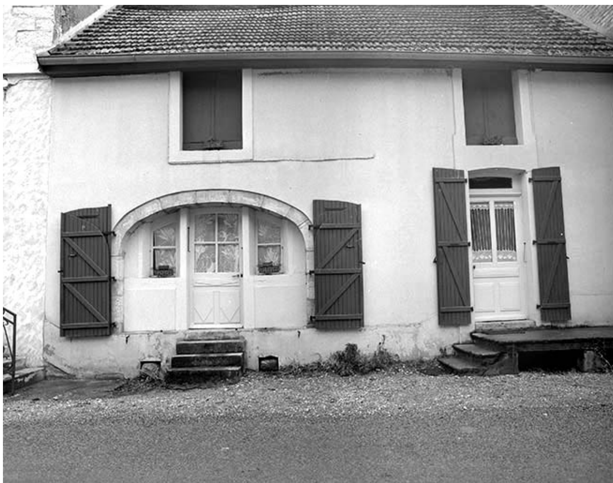
Façade antérieure du logement d'ouvriers.
