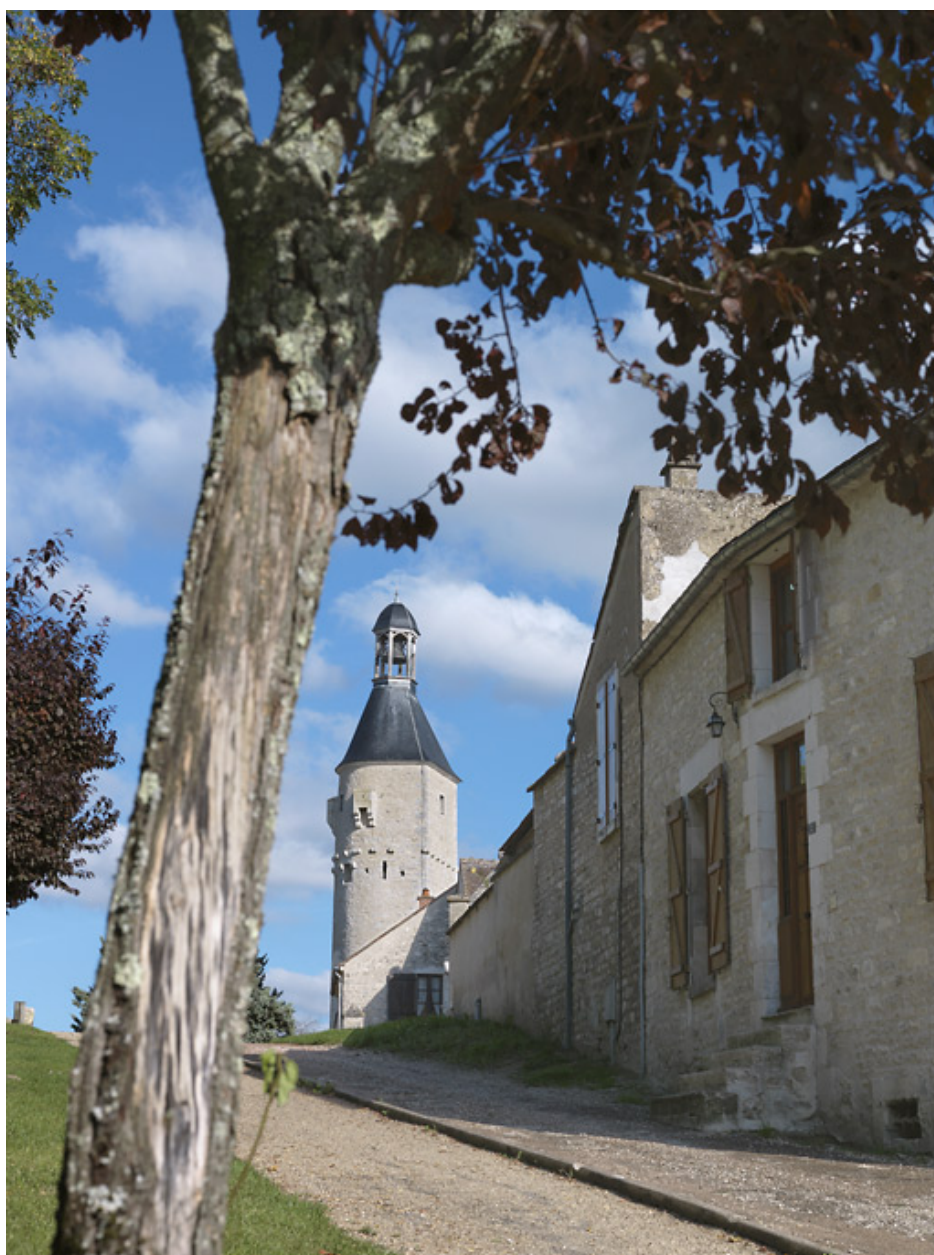
Vue d'ensemble de la tour de l'horloge.
