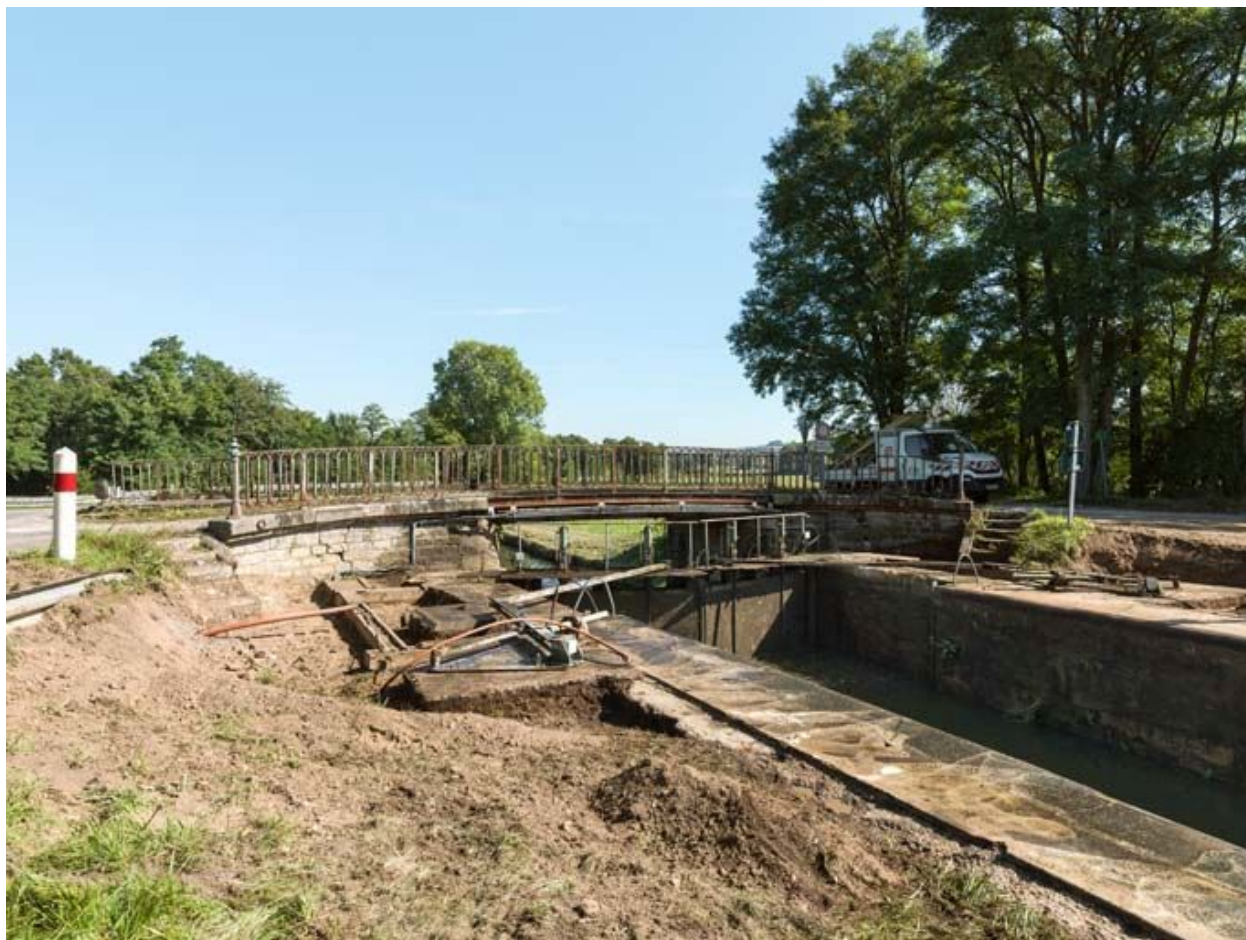
Vue d'ensemble du site d'écluse.
