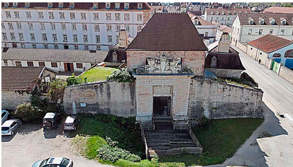
Vue aérienne de la porte.
