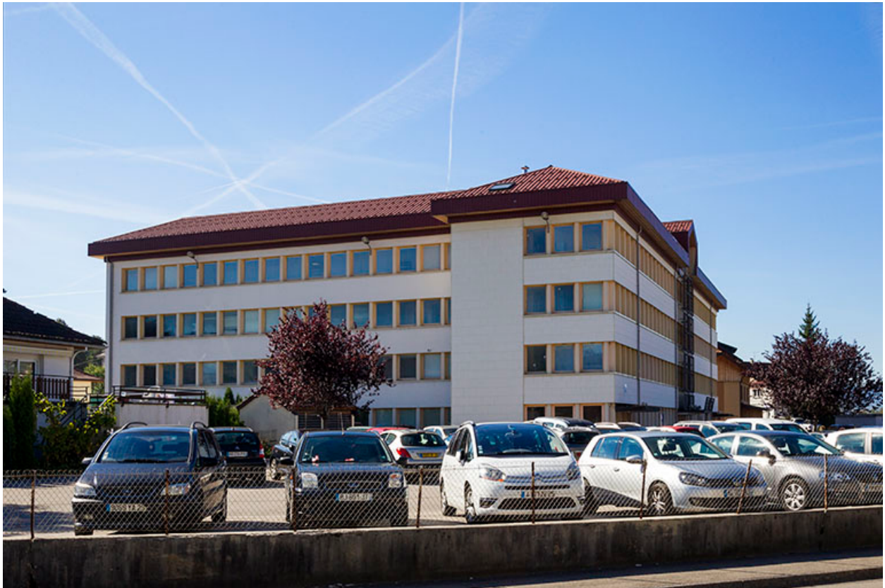
Usine : façade latérale gauche, de trois quarts.
