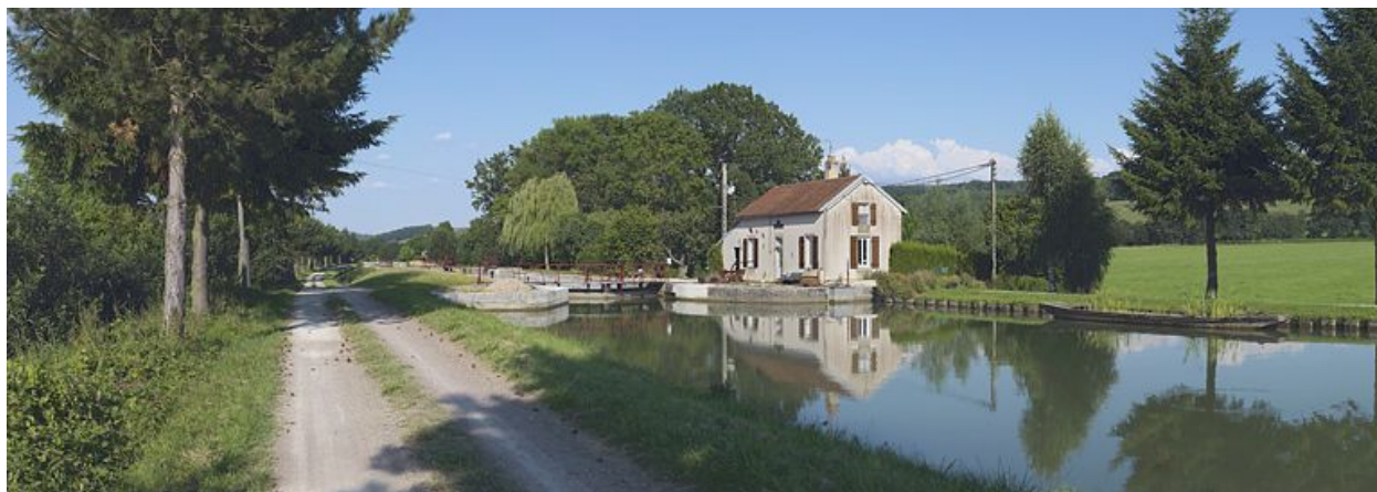
Le site d'écluse vu d'amont.
