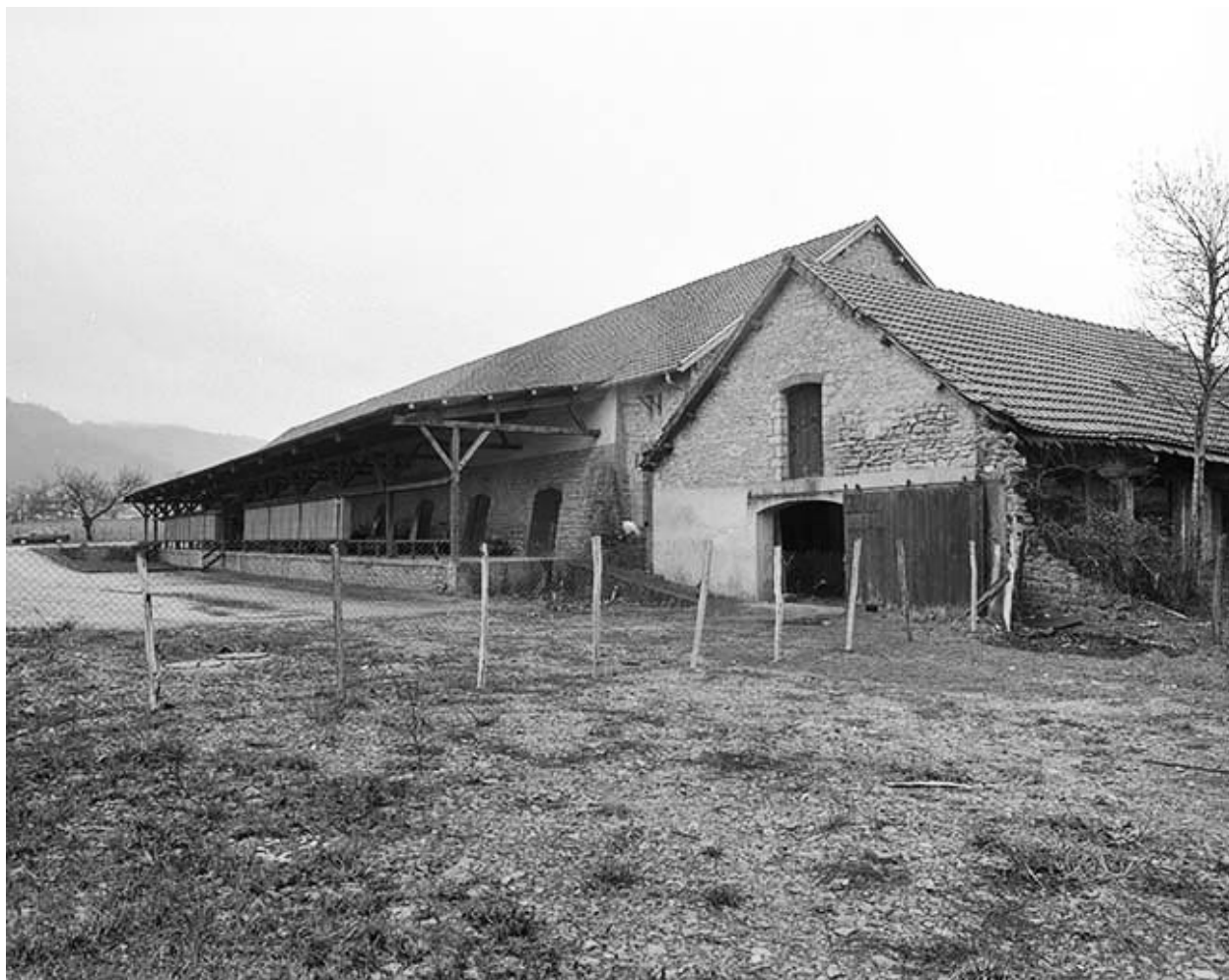
Magasin industriel et atelier de fabrication ruiné.
