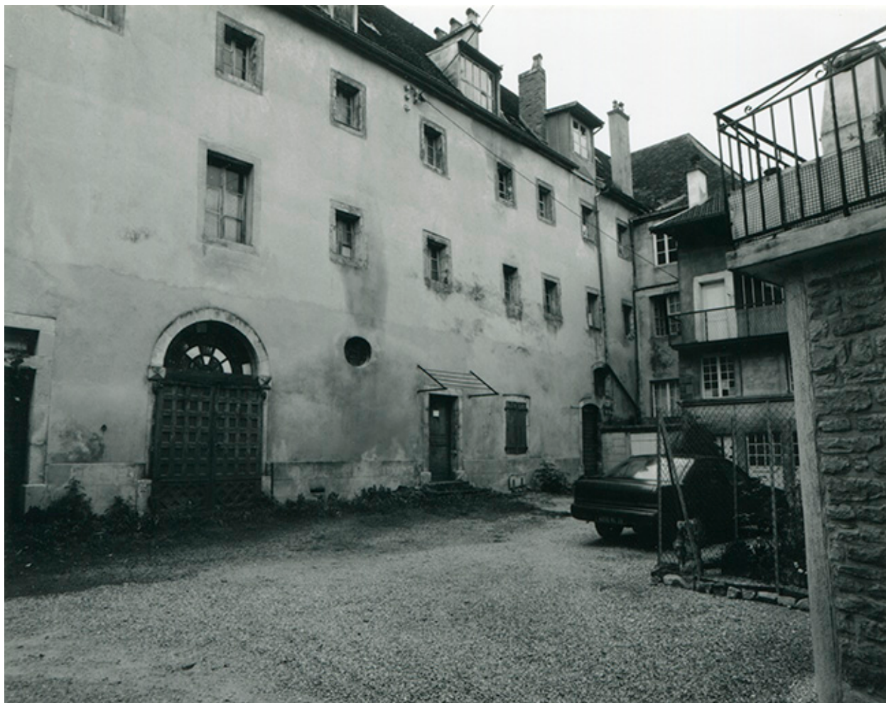
Façade nord du bâtiment conventuel, 1997.
