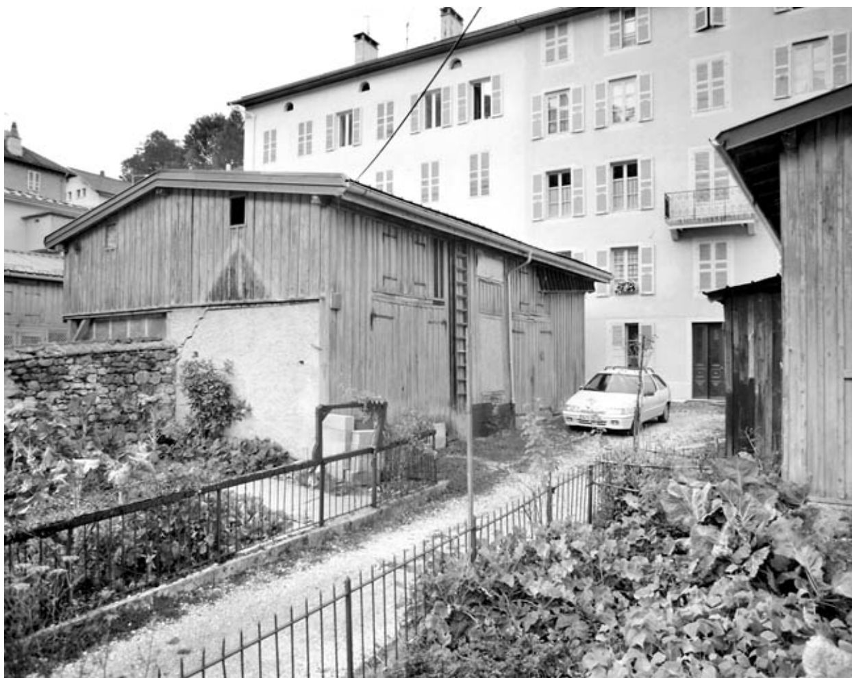
Bâtiment sud : bûcher et garage.
