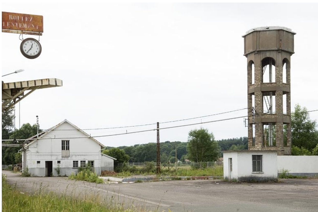
Garage à camions et château d'eau.
