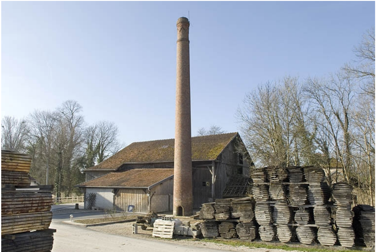
Vue d'ensemble de l'entrée depuis le nord-ouest.
