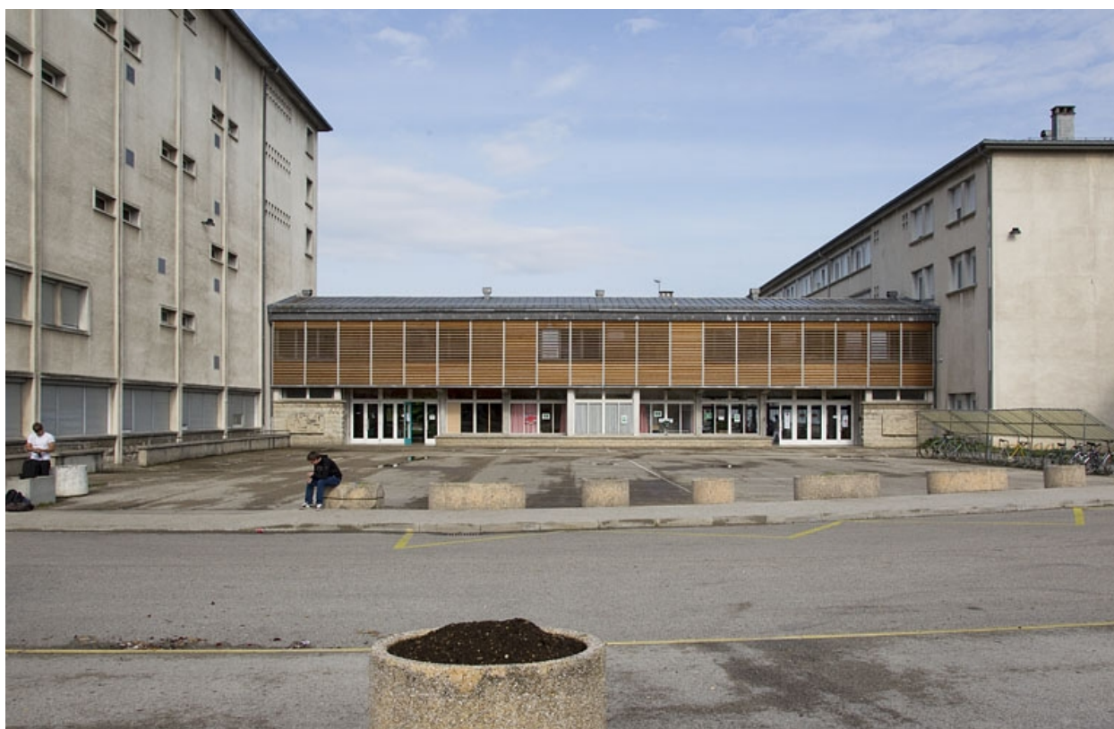
Bâtiment de l'administration : face antérieure.
